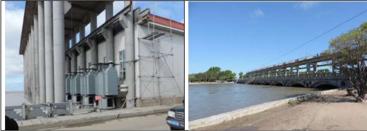
Рисунок 2 - Насосная станция (слева) и сбросное сооружение (справа) на перешейке,отделяющем оз. Малая Ханка от оз. Ханка
